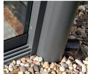
**PASSGENAUIGKEIT** | Schiebeanlagen von Düpmann fügen sich perfekt ein, der Regenabfluss ist in die Stütze integriert.
