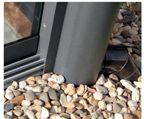
PASSGENAUIGKEIT | Schiebeanlagen von Düpmann fügen sich perfekt ein, der Regenabfluss ist in die Stütze integriert.
